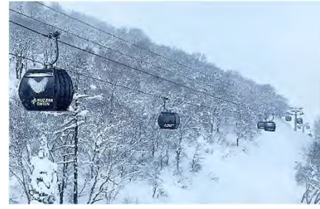
索道の更新に併せ、設置位置や滑走コースの構成を見直し、利便性・快適性を向上
